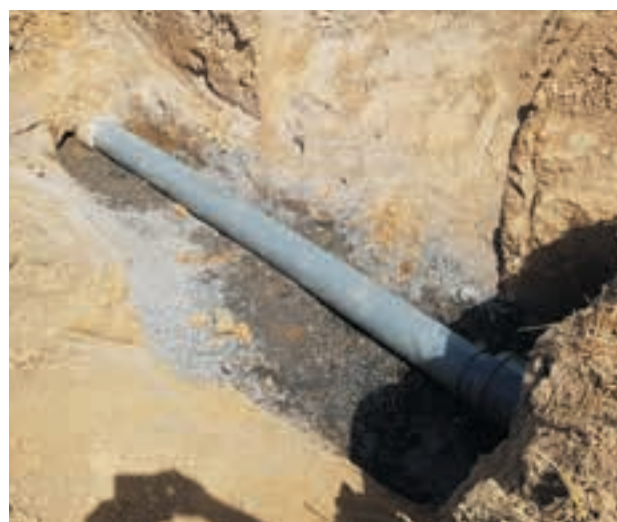
Remplacement du tuyau de décharge.
