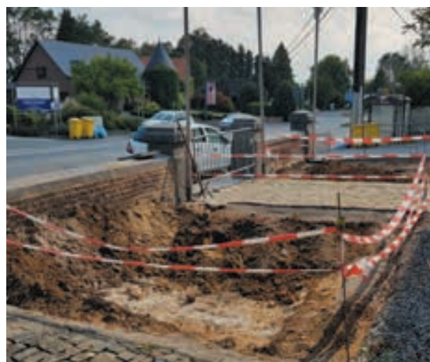
Travaux à l'entrée de l'administration pour y accueillir des plantations à l'automne.
