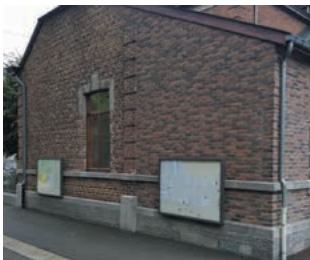
Afin de dégager la devanture de l'administration, les valves ont été déplacées sur le pignon droit de la maison communale.
